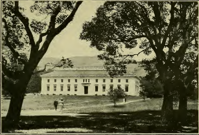
A. EDIFICIO DE LA ADMINISTRACIÓN, UNIVERSIDAD DE CALIFORNIA, BERKELEY, CAL.
